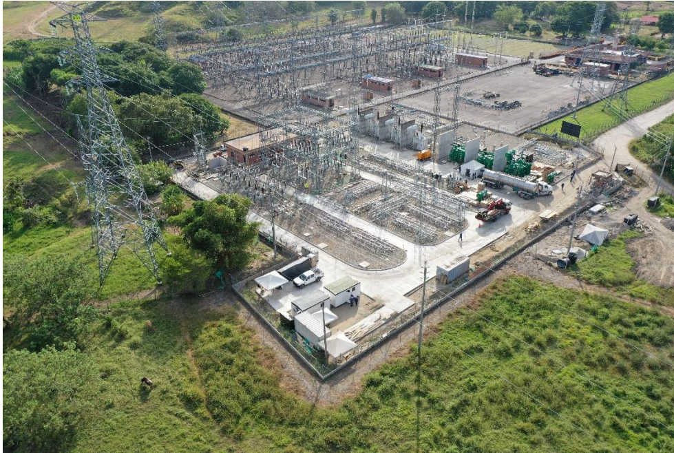
*Vista aérea Subestación Purnio (La Dorada – Caldas)
