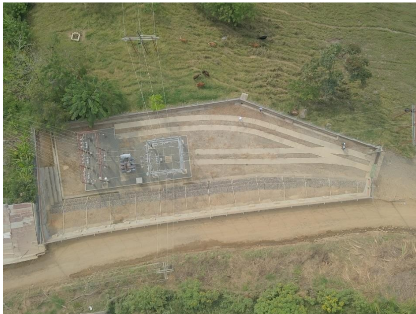
*Vista aérea Subestación El Dorado (Marmato – Caldas)
