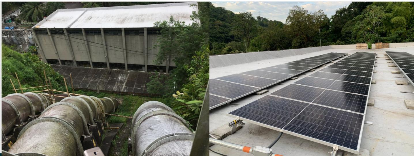
**Planta San Francisco:** Instalación solar en nuestra planta de generación San Francisco, con una capacidad instalada de 20,4 kWp.
