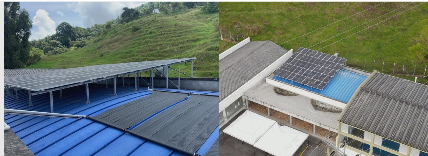
**Restaurante CHEC:** Segunda instalación solar fotovoltaica dentro de las instalaciones de la Estación Uribe para abastecer el 50% de la demanda de este edificio, a partir de 50 paneles instalados, con una capacidad de 20kWp.
