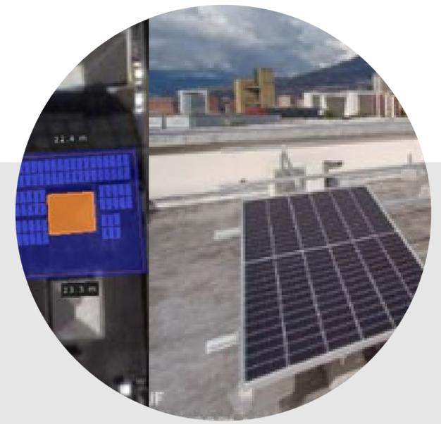
**Gobernación de Caldas:** En convenio con la Promotora Energética del Centro, participamos en modalidad PPA para la instalación un Sistema Autogenerador de Energía solar con una capacidad instalada de 156 kWp, que generará 32.450 kWh/mes y 389.400 kWh/año, significando un descuento en el CU entre el 8 al 15%.
